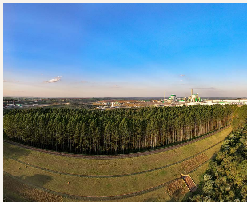
Complexo Industrial da Unidade Puma, em Ortigueira (PR)
